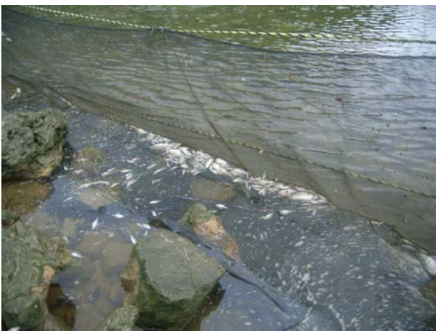
写真-3 減勢工副ダム直下の流出防止ネット
