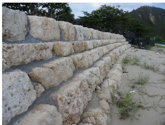
写真-3 階段型石積護岸
