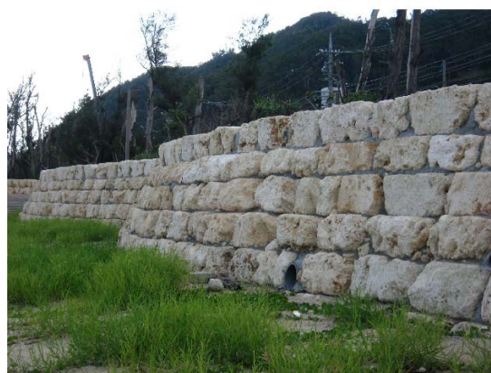
写真-4 多自然型石積護岸
