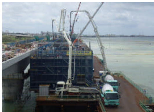
写真-3 柱頭部コンクリート打設
