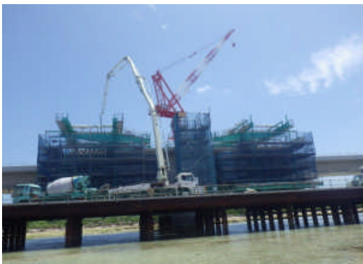
写真-5 張出部コンクリート打設
