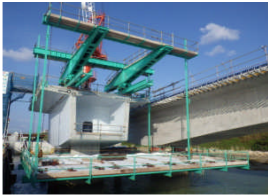
写真-4 架設用移動作業車組立
