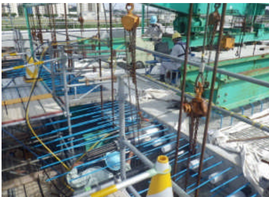
写真-6 PC 緊張（縦締め）
