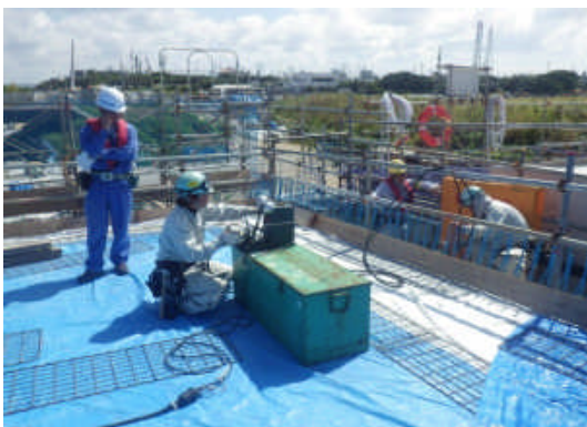
写真-7 PC 緊張（横締め）
