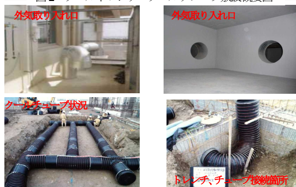
写真2 クールトレンチ・クールチューブ敷設状況
