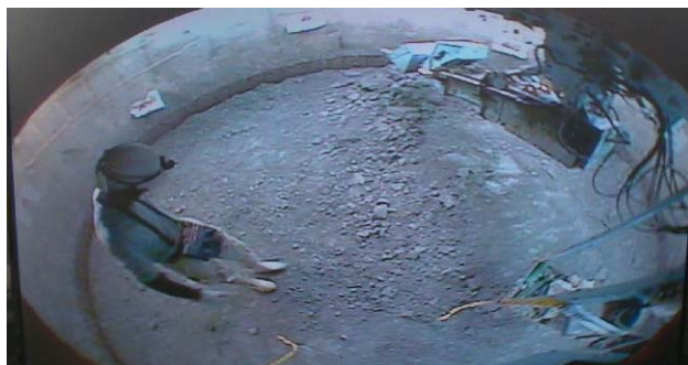
写真-12 島尻泥岩整形
