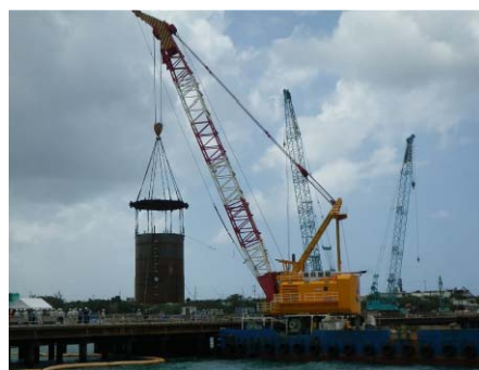
写真-2 鋼殻ケーソン吊込み状況
