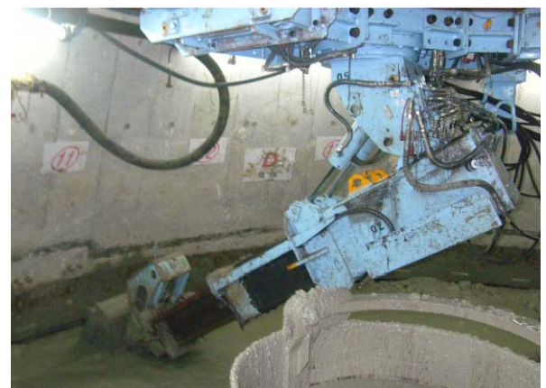
写真-6 スリム用天井走行式掘削機
