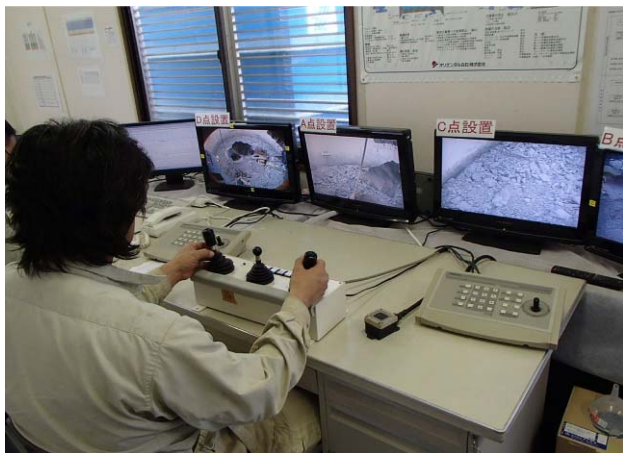
写真-7 無人機械掘削状況
