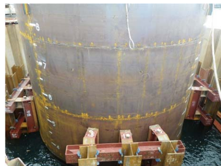
写真-3 鋼殻据付け状況
