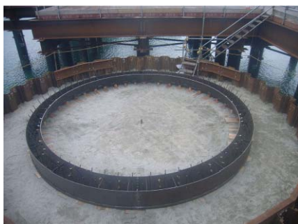
写真-1 築島工（刃口金物据付け）
