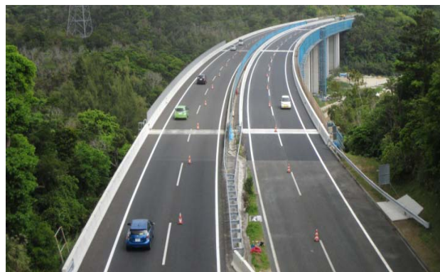
写真-7 対面通行規制切り替え完了
