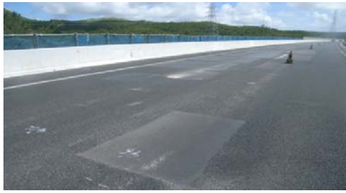
(a) 路面補修状況
