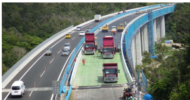
写真-6 SMA舗装施工状況
