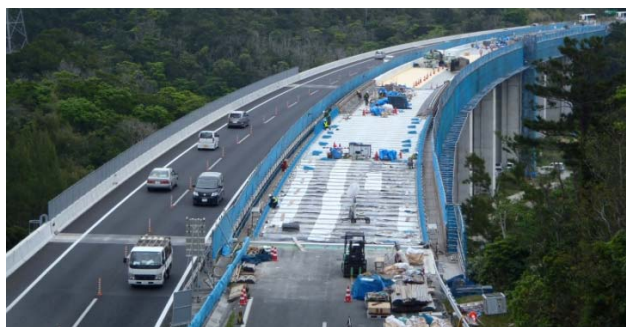
写真-5 壁高欄工・床版防水工施工状況
