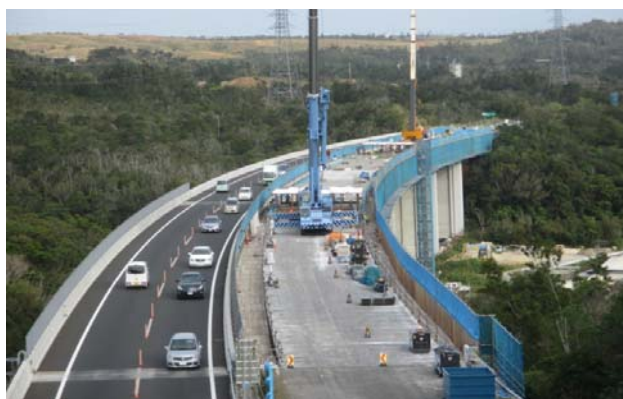
写真-4 伊芸高架橋の周辺状況と床版取替状況
