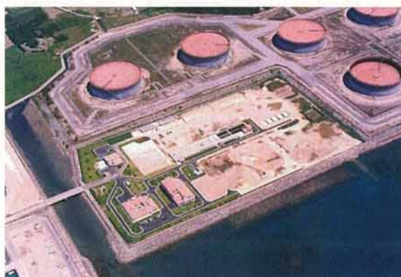
西原浄化センター
