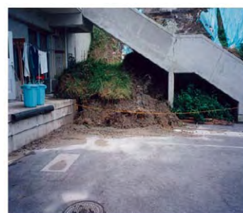
小谷園施設内階段下の 土砂崩落状況
