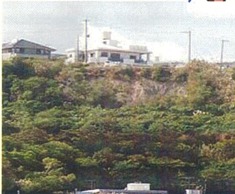
②南風原町新川(平成11年)
