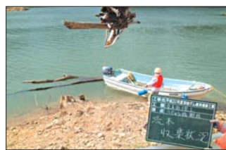
流木処理: ダム貯水池に流れてくる流木を集積し搬出します。
