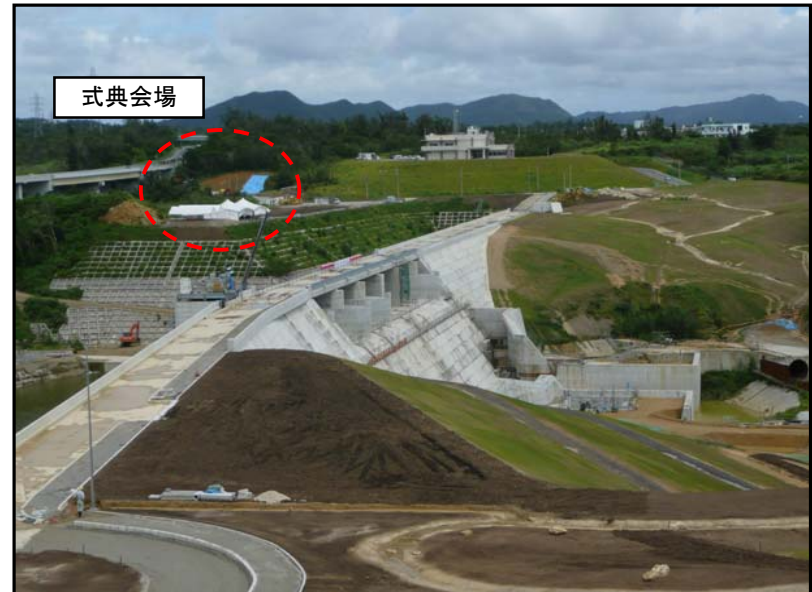
○ダム右岸下流側から
