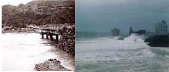
チリ津波による大浦橋の被害 (1960年5月)
