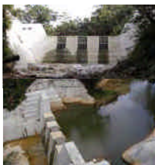
砂防えん堤(H13)
