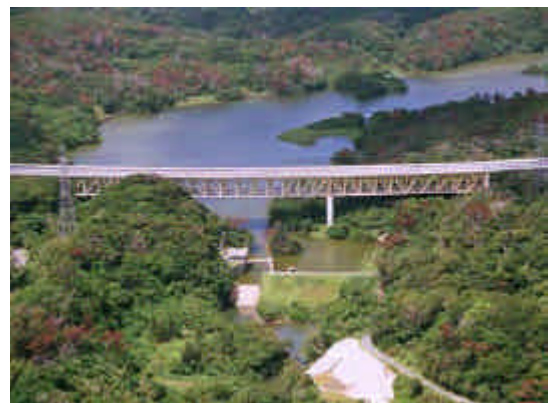
金武ダム現況
