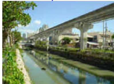
改修状況(久茂地公民館付近)
