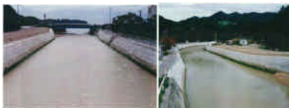
流路工(H3~H4)施工箇所
