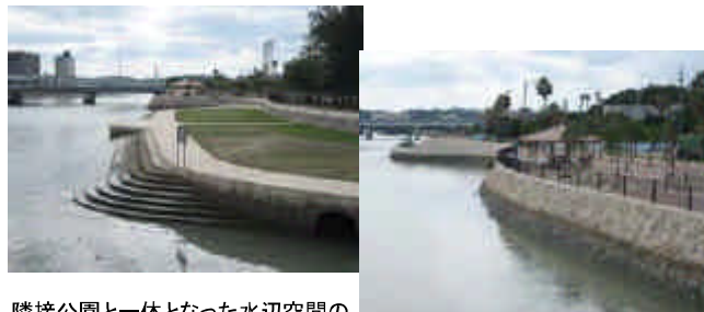
隣接公園と一体となった水辺空間の創出のため、緩傾斜護岸の整備実施(H10年度)
