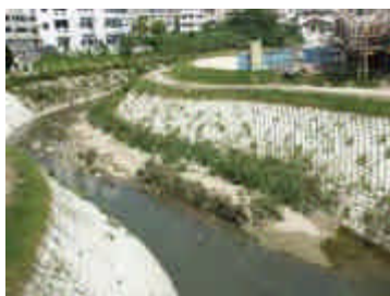
床上浸水地区(国場~仲間)の護岸整備を行い、浸水被害を解消した。(H13年度)
