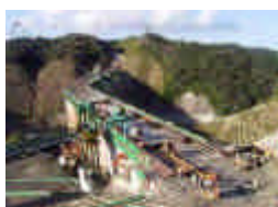
本ダムの状況
