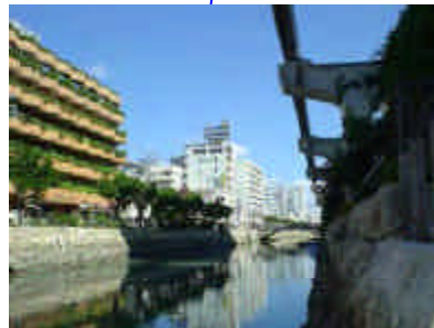
改修状況(御成橋付近)
