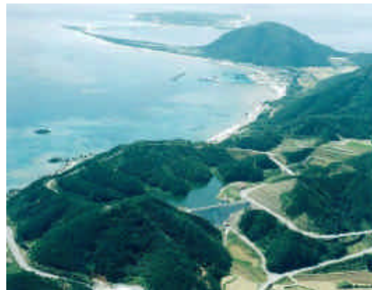
我喜屋ダム (伊平屋村) 出典：沖縄県土木建設部河
