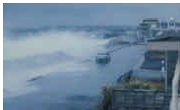
台風20号による越波状況 (平成2年9月)
