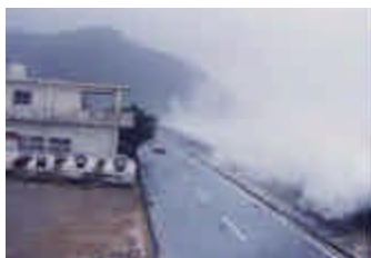
台風21号による越波状況 (平成8年9月)
