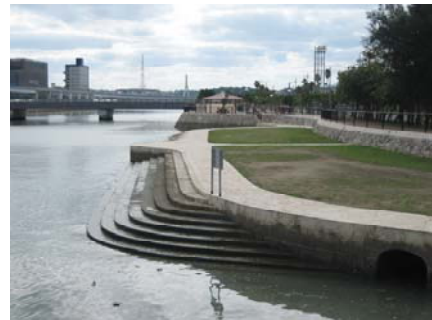
隣接公園と一体となった水辺空間の創出のため、緩傾斜護岸の整備実施 平成13年度完成
