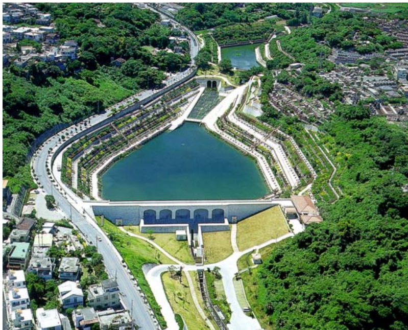
金城ダム全景
