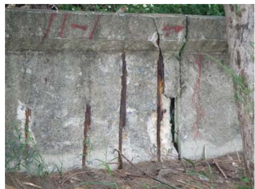
琉球政府時代に築造された海岸護岸(松田潟原海岸)
