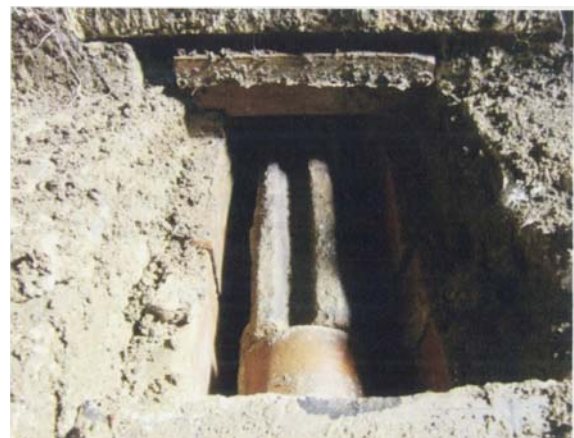
水道管遺構（凝灰岩）
