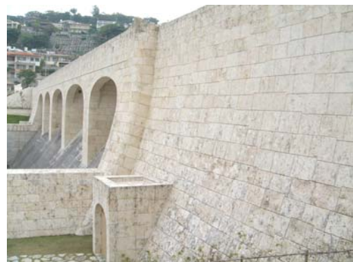
堤体下流面（石張り）
