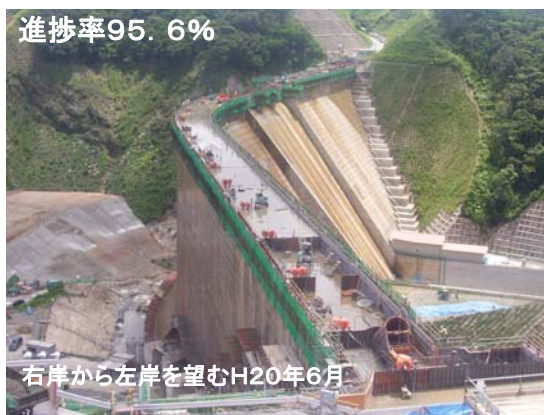
大保ダム進捗状況 （沖縄北西部河川総合開発事業）
