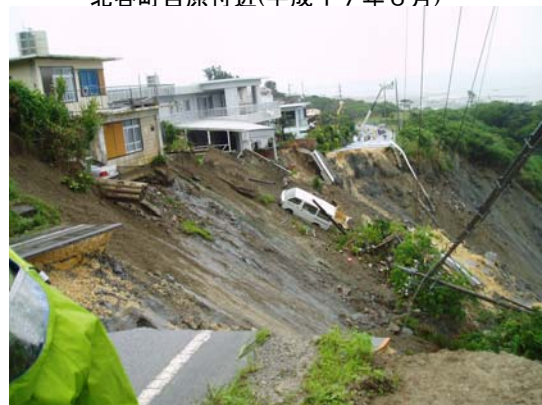
集中豪雨による地すべり被害（中城村） 村道坂田線より撮影（平成18年6月12日）
