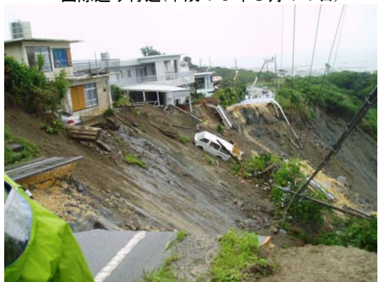
集中豪雨による地すべり被害（中城村）
