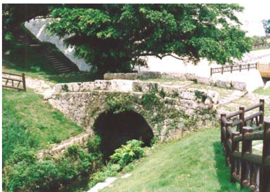
金城ダム上流のヒジ川橋
