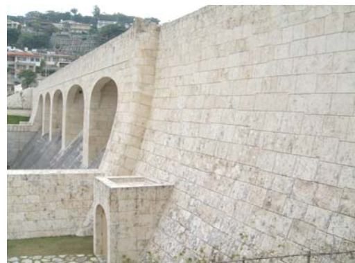
堤体下流面（石張り）
