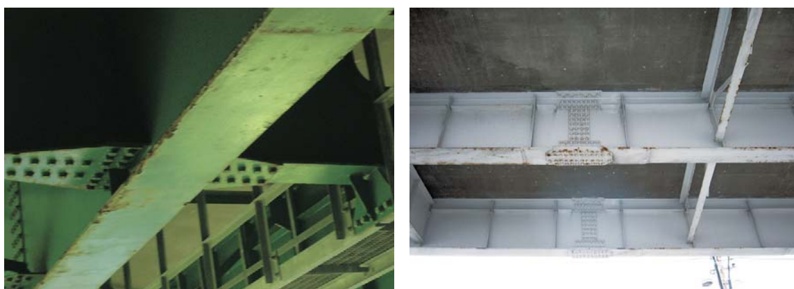
写真－ 1.1 一般部の塗膜状況
