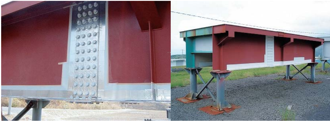
写真－４ チタン箔シートの貼り付け作業状況
