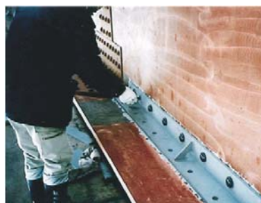
写真- 7.2 補強材取付状況
