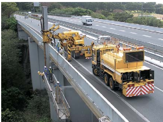
写真－ 7.4 水洗状況
