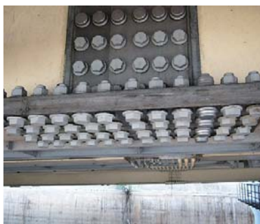
写真－5.2 ボルトキャップ取付状況
