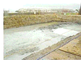
③改良ヤードに仮置
