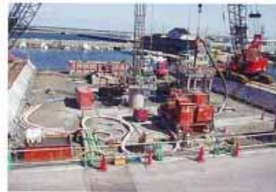
橋脚基礎杭の施工現場
