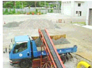
⑤改良土 ダンプトラックによる小運搬
