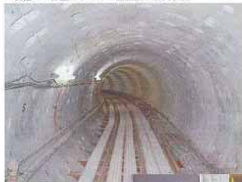
二次覆工一体型セグメント組立後の坑内状況
