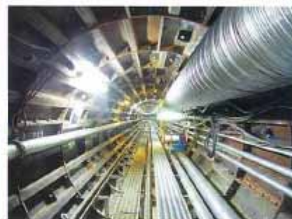
トンネル工事内部
