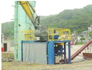
④プラントによる改良
