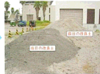
⑥改良土 場内に仮置
