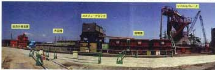
現場全景(最新分級システム)
