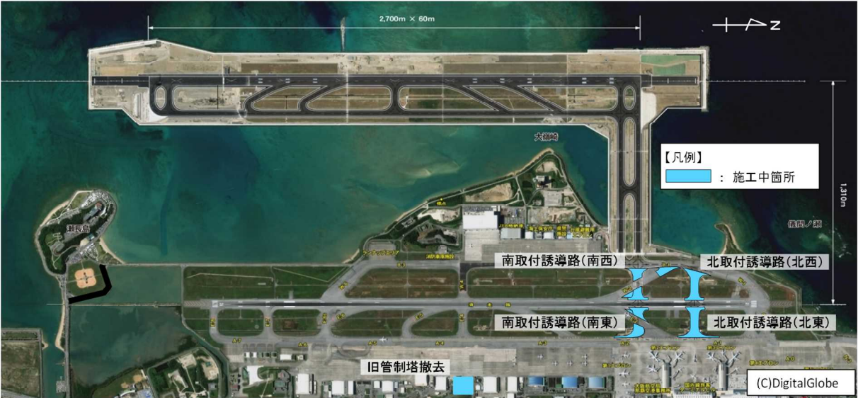
図－ 4.1.2 令和 2 年度施工位置
