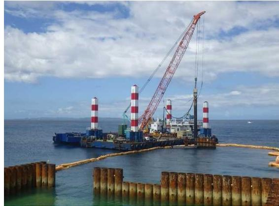
② 【仮設棧橋2撤去】鋼管矢板引抜状況
