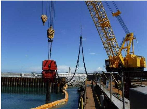
① 【仮設棧橋1撤去】鋼管矢板引抜状況
