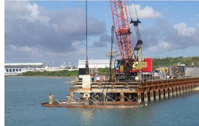
③ 【仮設橋撤去】H鋼杭引抜作業
