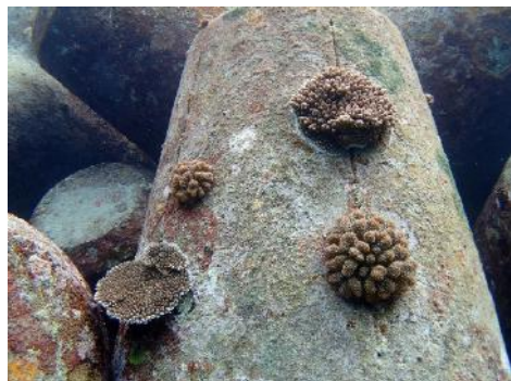
溝加工部の着生状況
