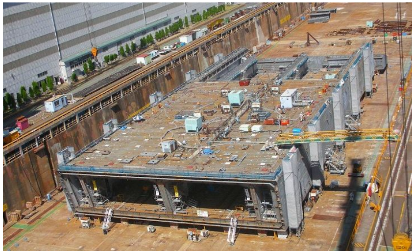
鋼殻組立て状況(平成19年8月)
