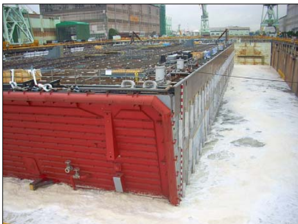
ドック内注水状況
