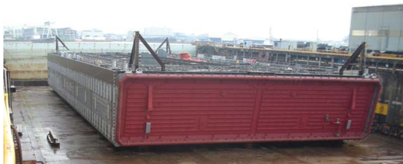
鋼殻組立て完了状況(平成20年1月)
