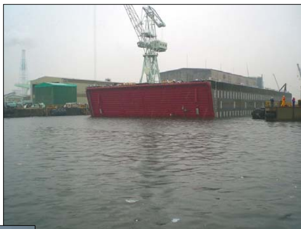
ドックよりの引き出し状況
