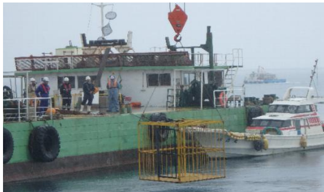
沖縄県港湾空港建設協会による障害物の除去（航路啓開）
