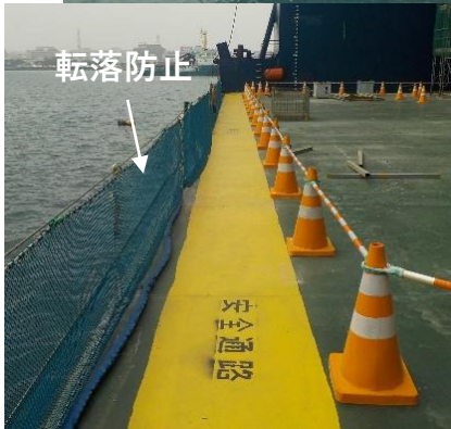
機械との接触や落下物から身を守るために 作業をする人が安全に通行できる通路を確保しています。
