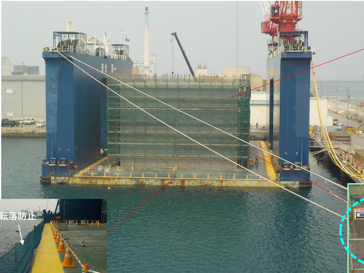
機械との接触や落下物から身を守るために 作業をする人が安全に通行できる通路を確保しています。
