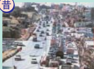
国道58号那覇市安謝付近（昭和47年）
