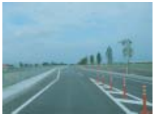
与那原バイパス 平成17年度部分暫定供用区間
