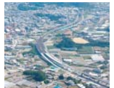
豊見城東道路暫定共用部分 (平成20年)
