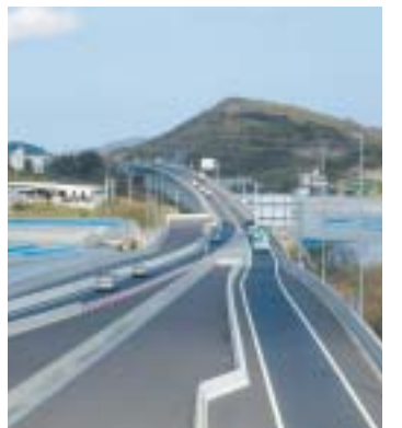
豊見城東道路暫定共用部分 (平成15年)
