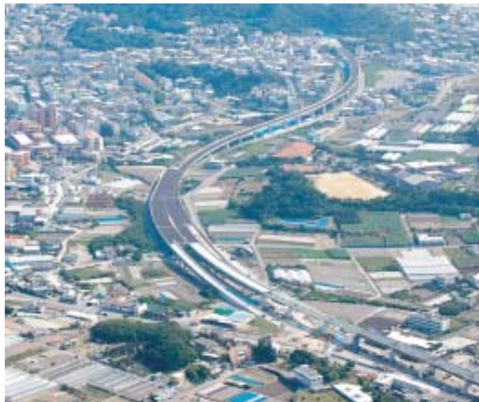
豊見城東道路（平成19年度供用区間）
