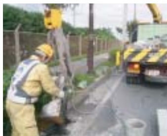
構造物の補修
