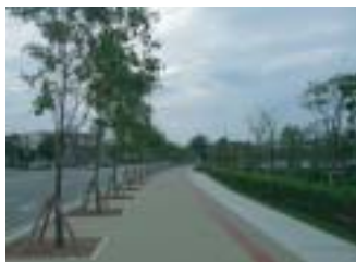
南風原バイパス 平成17年度部分暫定供用区間
