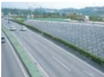
国道329号西原地区法面対策
