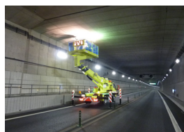
トンネル点検車
