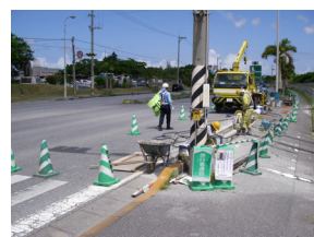
構造物の補修
