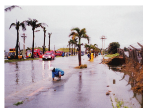
台風による災害状況
