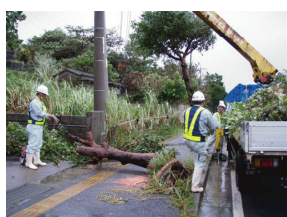
復旧作業（風倒木処理）
