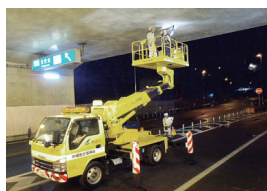
トンネル点検車
