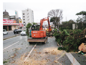
復旧作業 (風倒木処理)
