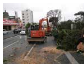
復旧作業（風倒木処理）
