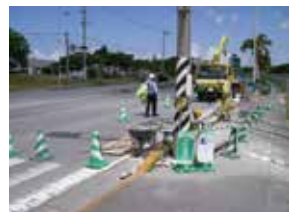
構造物の補修
