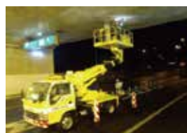
トンネル点検車
