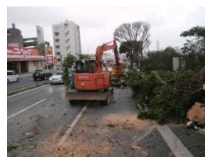
復旧作業（風倒木処理）
