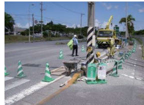
構造物の補修
