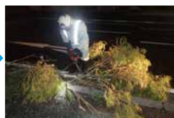
復旧作業(撤去のため倒木を切断)
