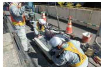
排水構造物補修
