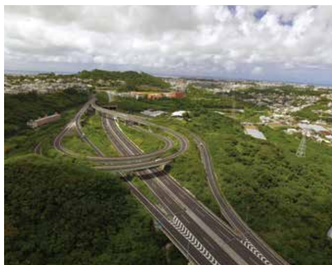
平成26年度 開通区間
