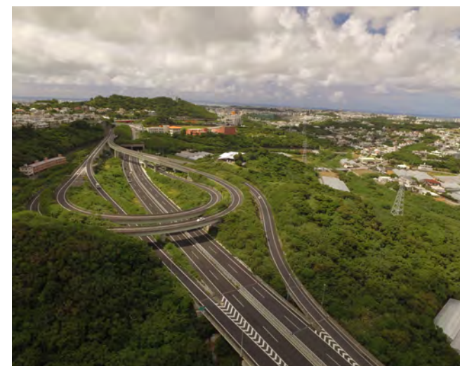
平成26年度 開通区間
