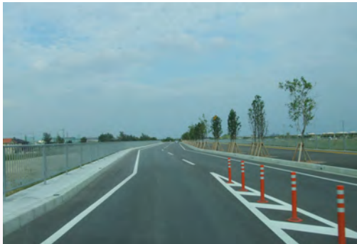
与那原バイパス 平成17年度部分暫定開通区間
