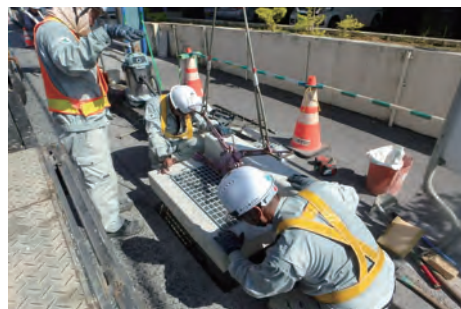
排水構造物補修
