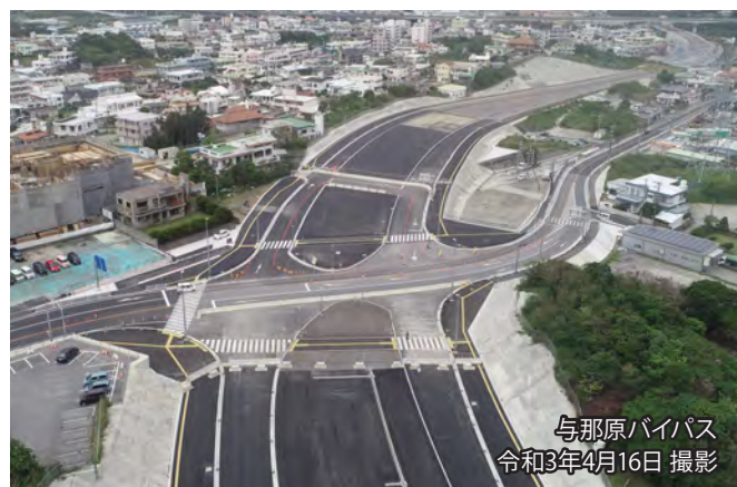
南風原バイパス 令和2年7月22日撮影
