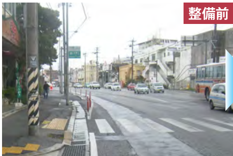
電線共同溝の整備事例(沖縄市コザ十字路)
