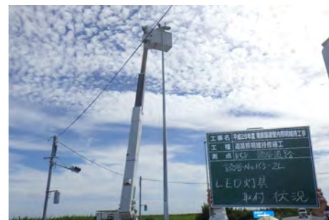
不灯箇所の機器点検や灯具取替え
