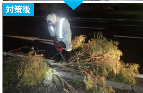
台風による被害状況と復旧作業(撤去のため倒木を切断)
