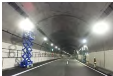
不灯箇所の機器点検や灯具取替え
