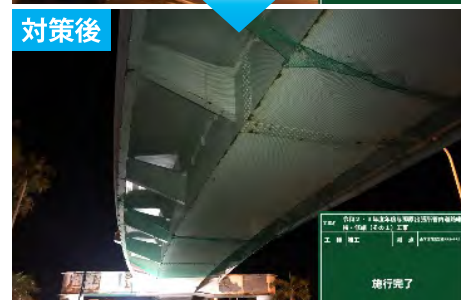
落下防止ネットの設置
