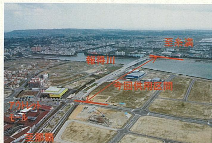
那覇市方面から豊見城道路を望む (H19.1.10時点の状況)
