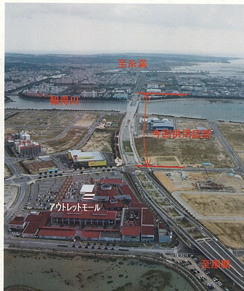
那覇市方面から豊見城道路を望む(H19.1.10時点の状況)
