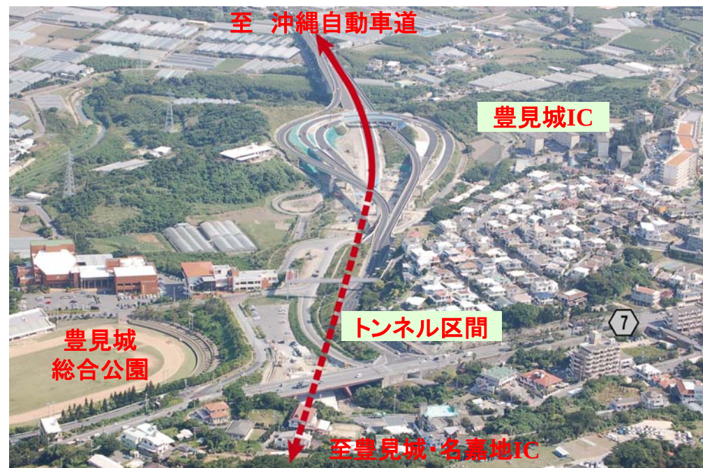
豊見城IC周辺の工事状況 (H19.11.13時点の状況)
