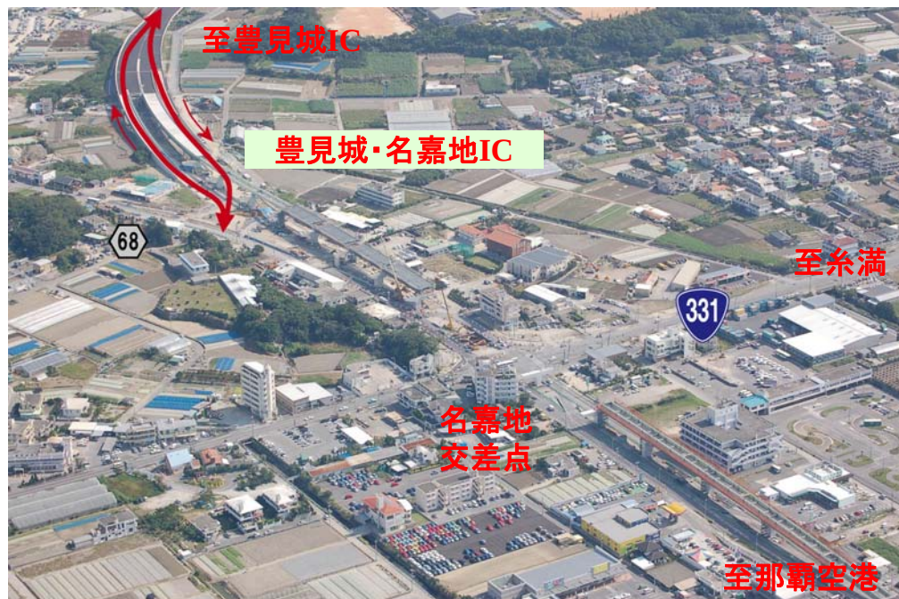
豊見城・名嘉地IC周辺の工事状況 (H19.11.13時点の状況)
