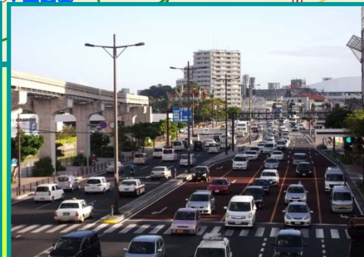
【国道58号明治橋】 H23. 8月24日（水）撮影
