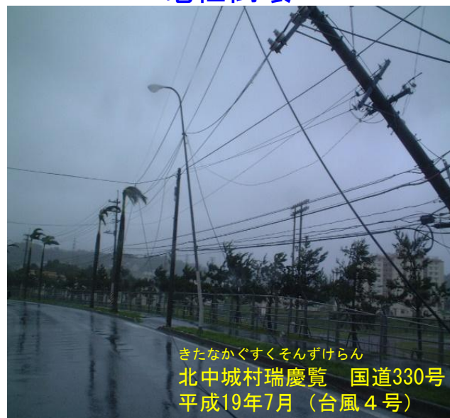
電柱倒壊
