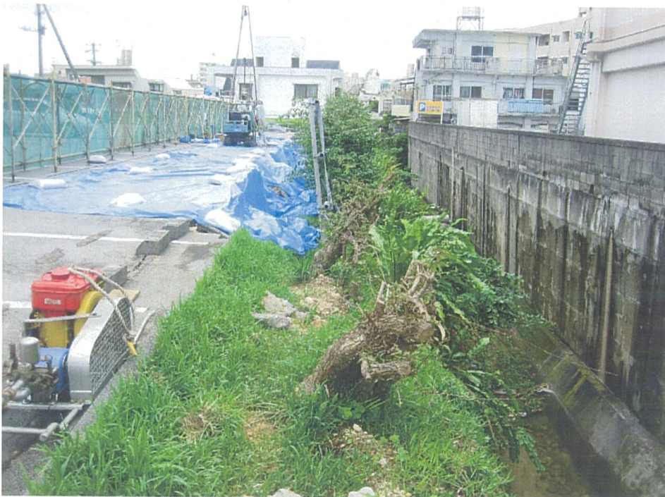
調査ボーリング状況(6月15日撮影)
