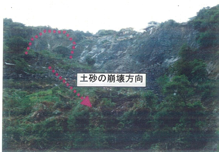
①小崩壊斜面の状況
