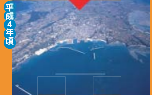
▲宮古とともに港湾も近代化が進められています
