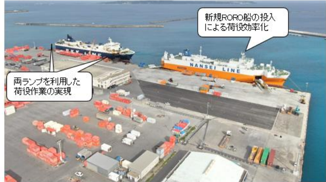
RORO船の荷役作業状況(漲水地区)
