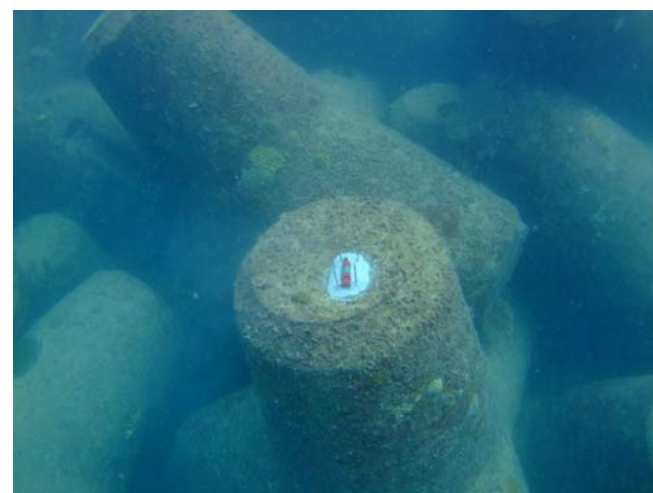
構造物への設置（T3-上層）
