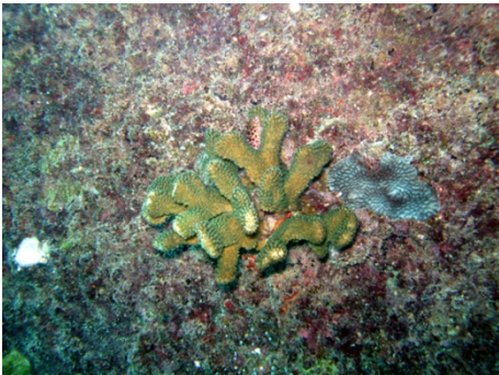
ケーソンの直立壁面の状況
