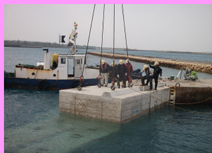
・ブロック据付(護岸部分)
