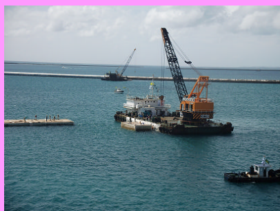
・ケーソン据付(護岸部分)
