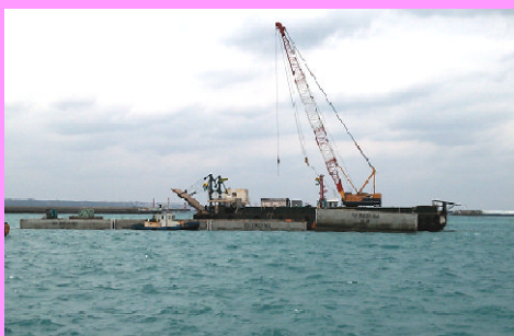
・ケーソン据付(岸壁部分)
