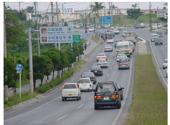
供用前の状況（石平交差点周辺）
