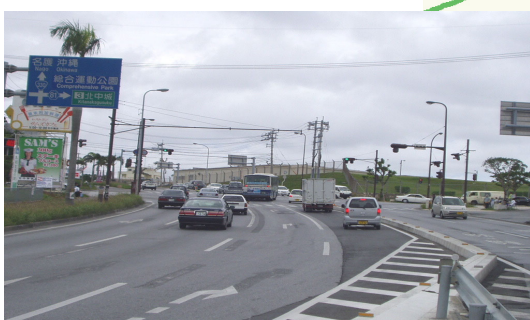
供用後の状況（石平交差点周辺）
