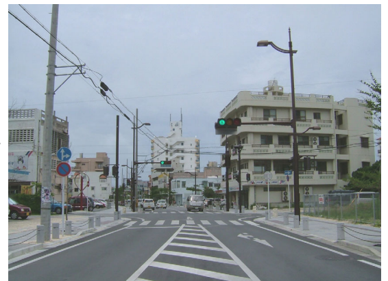
無電柱化実施後(電線・電柱未撤去)
