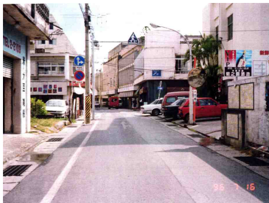
無電柱化実施前
