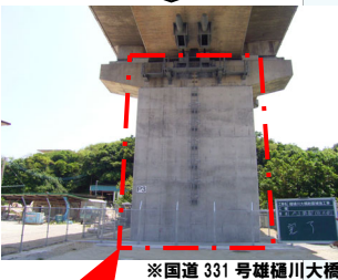
※国道331号雄樋川大橋
