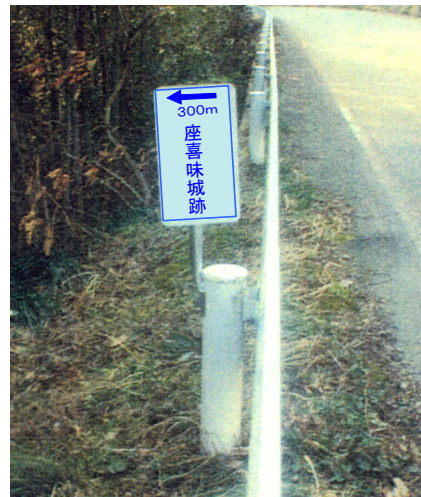
（例）既製品を使用した簡易標識（サンプル） ※写真提供：島根県浜田土木建築事務所によるものを一部改変
