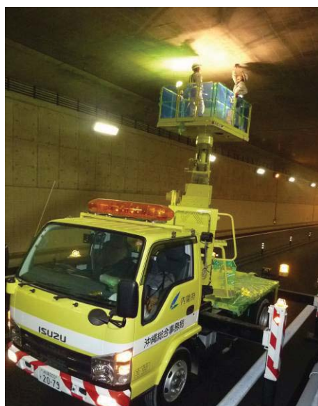
【トンネル点検車による点検】
