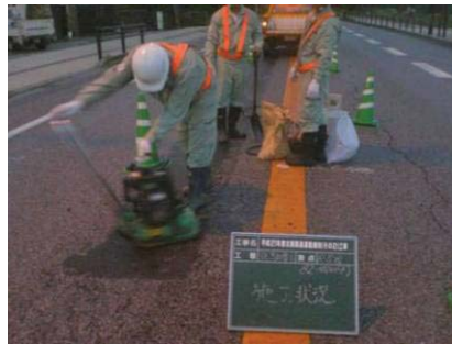
【補修作業状況】
