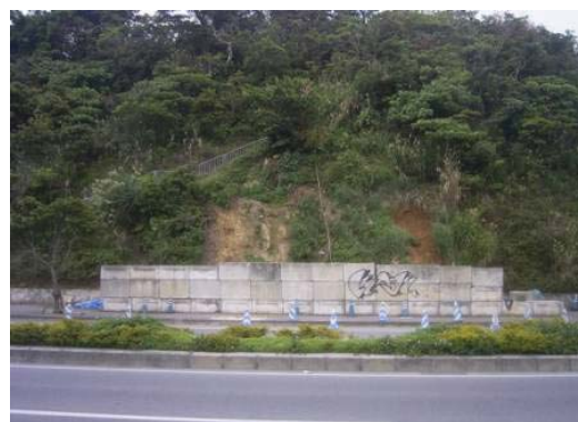
【応急復旧状況】
