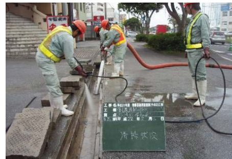
【側溝の清掃状況】
