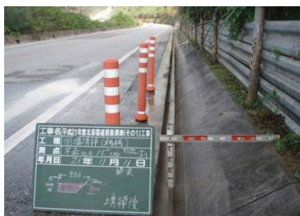
【側溝の土砂堆積 状況（清掃後）】
