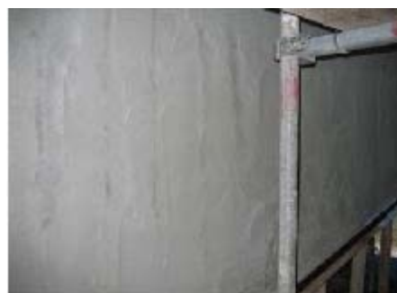
【補修後（ひびわれ補修）】
