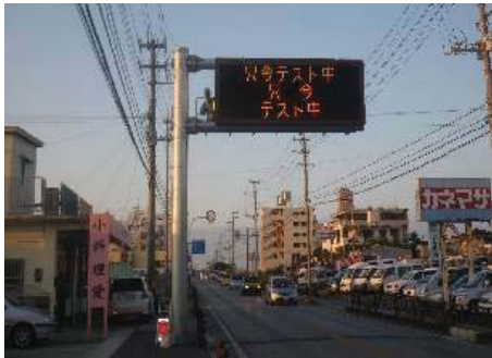
【道路情報板点検状況】
