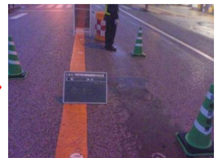
【補修後（一部打替え）】
