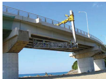
【橋梁点検車による点検】
