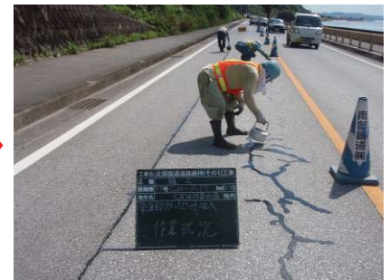
【補修後（注入完了）】
