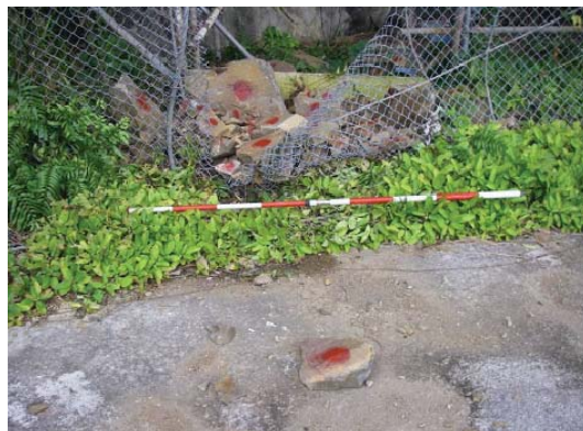
【法面転石の点検】
