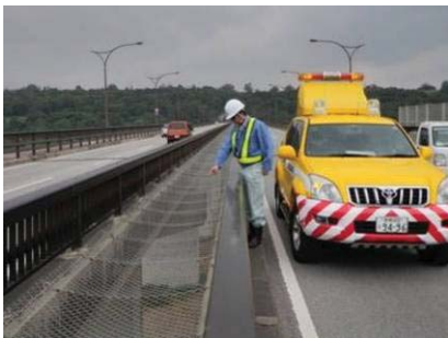
【定期巡回（橋梁）】
