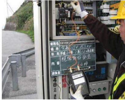
【電気設備点検 (道路施設監視カメラ)】
