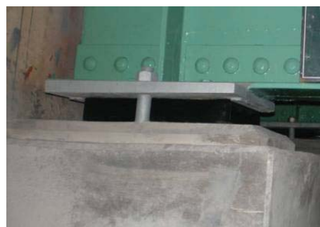
【補修後（支承の交換）】
