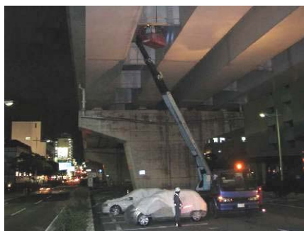
【高所作業車による点検】
