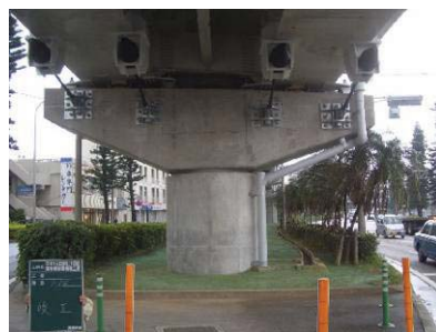
【対策後（コンクリート巻き立て ＋落橋防止装置）】
