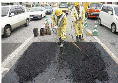
【補修作業状況】
