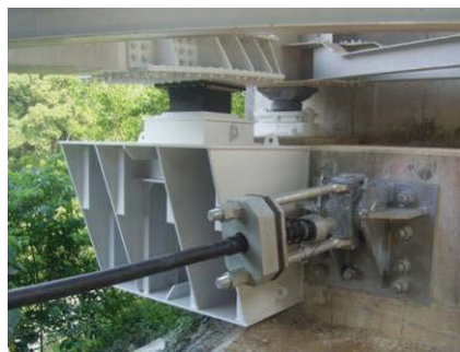
【対策後（落橋防止装置の設置）】
