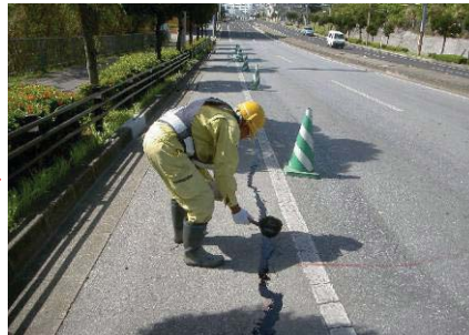
【補修作業状況】
