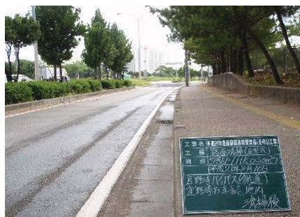
【道路沿いの 清掃状況（清掃後）】
