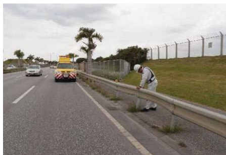
【道路附属物の異常発見】
