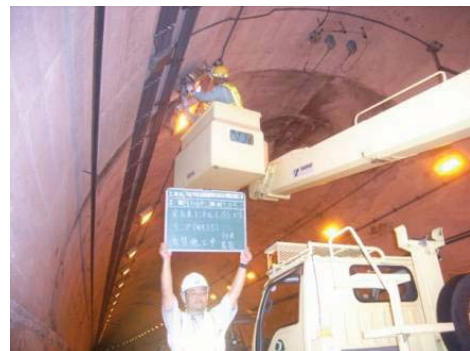
【トンネル照明ランプ交換状況】
