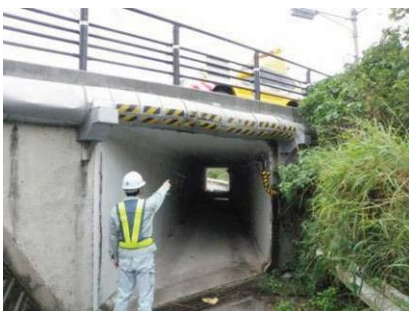
【定期巡回（横断管渠）】
