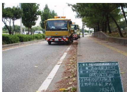
【道路沿いの 清掃状況（清掃前）】
