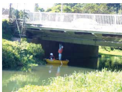
【船上からの点検】
