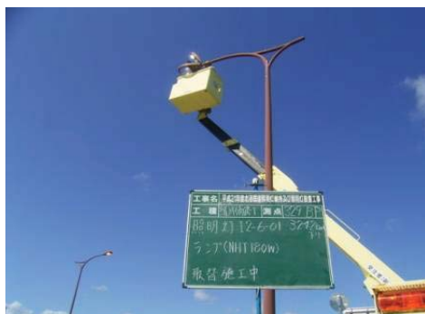
【道路照明灯ランプ交換状況】
