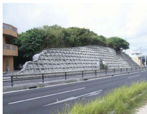
【対策後（落石対策）】
