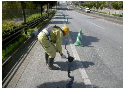
【補修作業状況】
