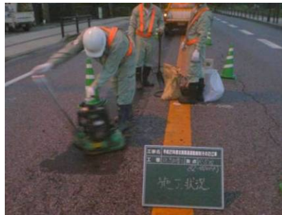
【補修作業状況】
