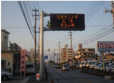
【道路情報板点検状況】
