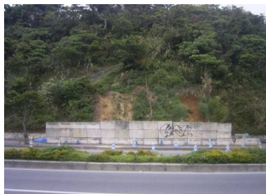
【応急復旧状況】
