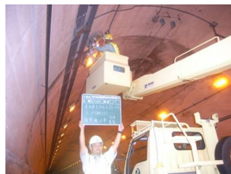
【トンネル照明ランプ交換状況】
