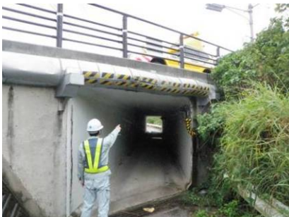
【定期巡回（横断管渠）】
