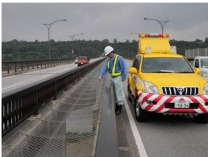
【定期巡回（橋梁）】
