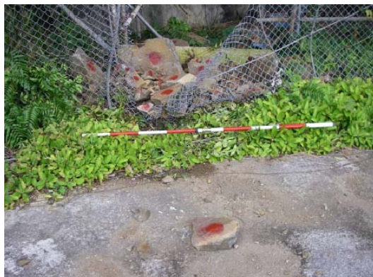
【法面転石の点検】
