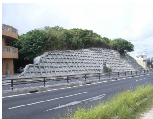
【対策後（落石対策）】
