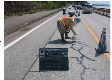
【補修後（注入完了）】
