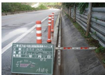
【側溝の土砂堆積 状況（清掃後）】
