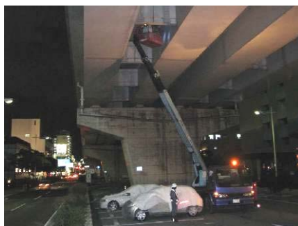
【高所作業車による点検】
