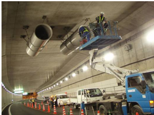
【トンネル非常用施設 (換気設備) 点検】
