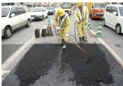
【補修作業状況】
