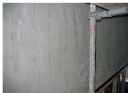
【補修後（ひびわれ補修）】
