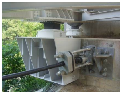
【対策後（落橋防止装置の設置）】
