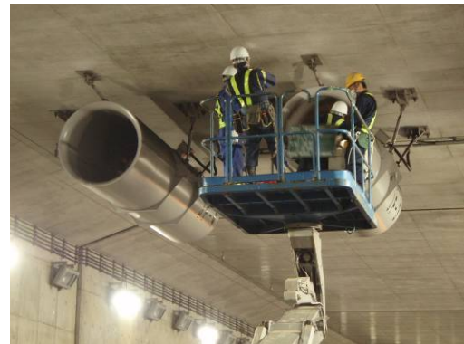
【トンネル非常用施設 (換気設備) 点検】
