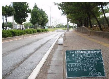
【道路沿いの 清掃状況（清掃後）】
