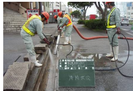
【側溝の清掃状況】
