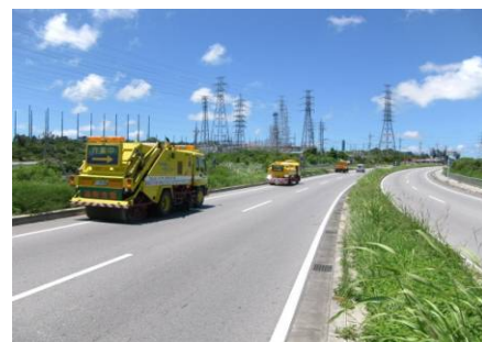
【路面清掃車による清掃】
