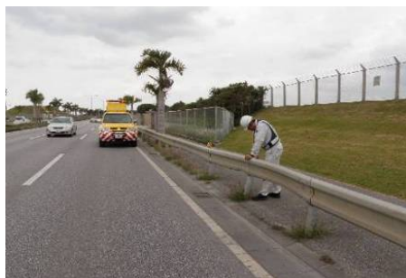
【道路附属物の異常発見】
