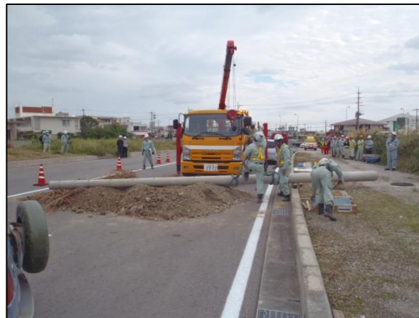
④ 倒壊電柱の撤去
