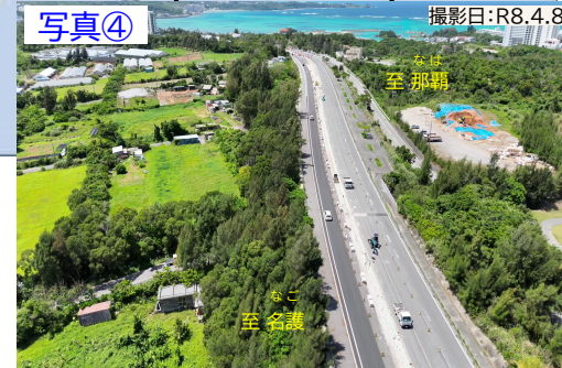
3号橋より終点側を望む
