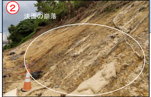
OIST交差点付近の法面(変状・対策状況)
