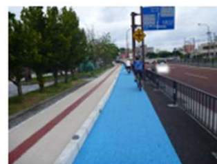
▲自転車道整備状況(国道58号 名護市)
